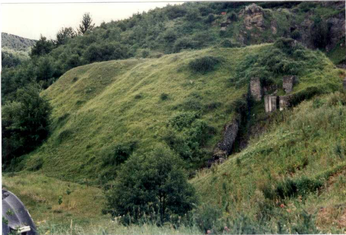
FOTO 8: Escombrera de una cantera de calizas en San Juan (próxima al límite con Vizcaya).
